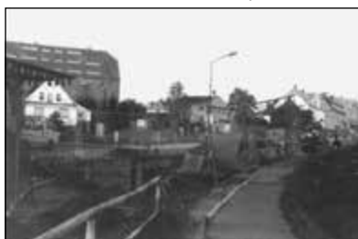
Kanalbau in der Äußeren Wolkensteiner Str., Fotos: Breyer
